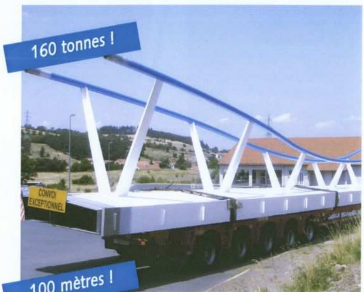
Élément de passerelle quittant l'usine de Taulhac
